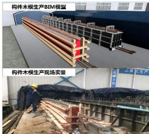
图 2-42 构件木模生产 BIM 模型及实景
